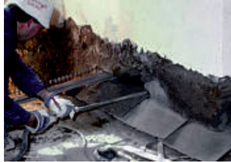
Bild 5. Restfugenverfüllung über Horizontalabdichtung mittels Spritzmörtel im Hochdruckverfahren
