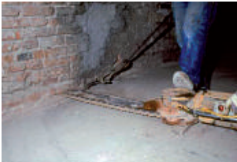
Bild 3. Mauerwerkstrennung mittels Mauerfräse
