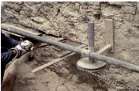
Bild 4. Mauerwerkstrennung mittels Seilsäge
