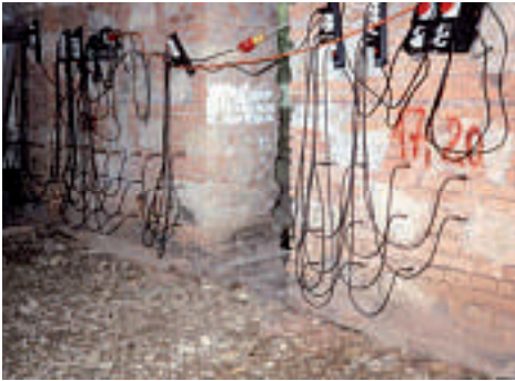
Bild 7. Mauerwerksentfeuchtung - Heizstabtechnik
